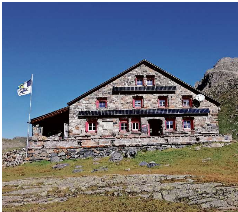
Die Vorbereitungsarbeiten für die Renovation der Grialetsch-Hütte laufen auf Hochtouren.
