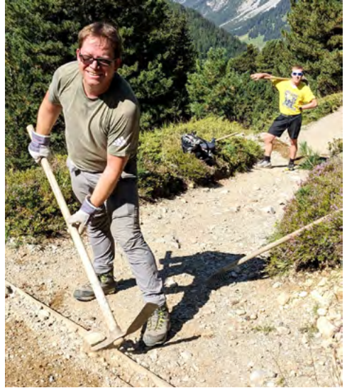
Querabschlag putzen - Ausgeputzt fliesst das Wasser nicht mehr drüber
