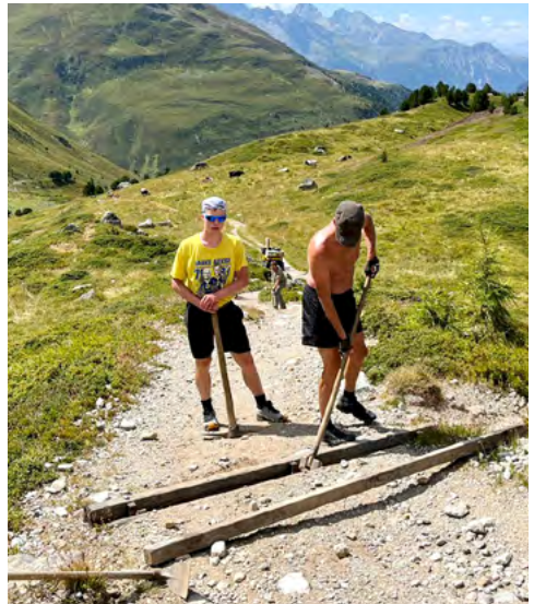
Eine nützliche, gesäuberte Rinne im Steilstück
