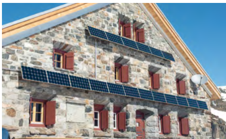
18 bisherige Panels an der Südfassade
