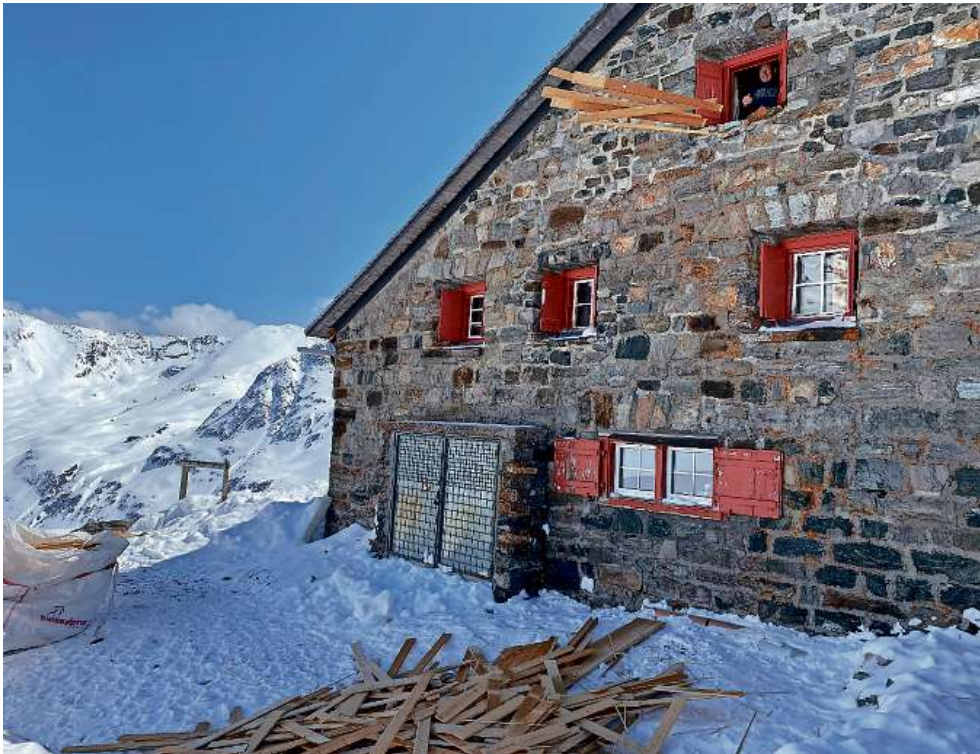
Alles muss raus: Die Schlafräume im Obergeschoss werden leergeräumt.
