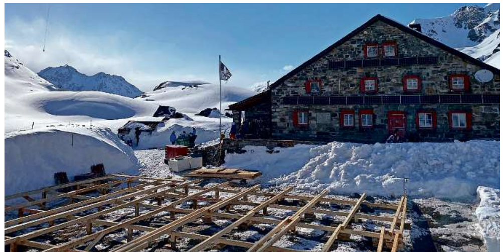
Dank vieler helfender Hände ist der Unterbau für das Containerdorf bereit.
