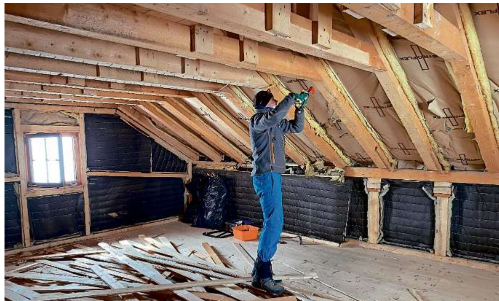
Im übrig gebliebenen Rohbau kann dann neu eingerichtet werden.
