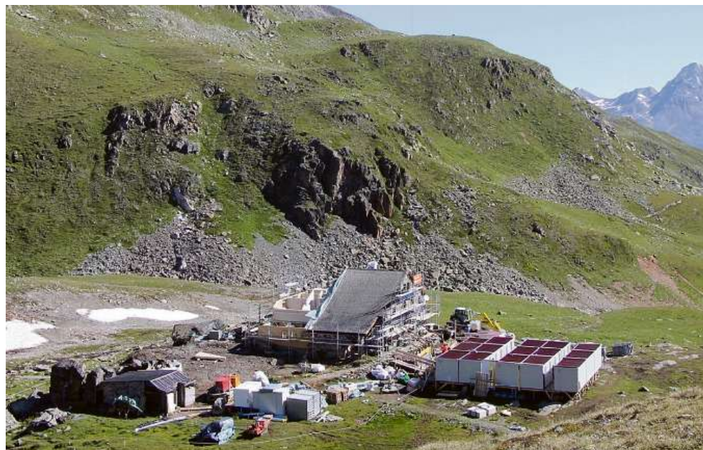
Die Baustelle im hochalpinen Gelände.
